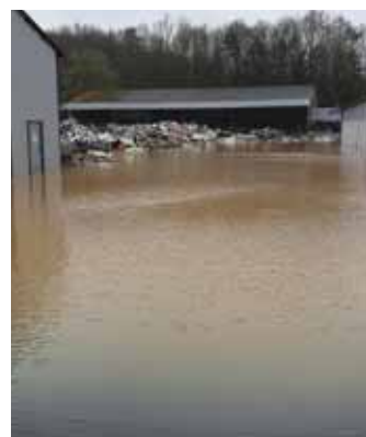
Début février, la montée des eaux a atteint les déchets stockés dans l'ancienne usine. PHOTO DR
