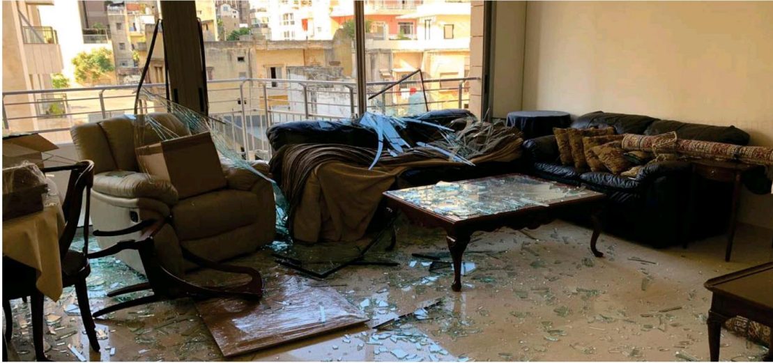
Une maison endommagée à Beyrouth. - Crédit photo : Courtoisie Aline Kahawaty
