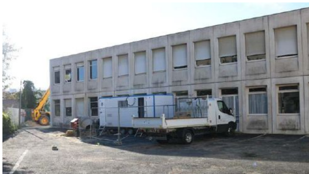
De nombreux travaux sont en cours dans les écoles du Mée-sur-Seine © La Rep77
