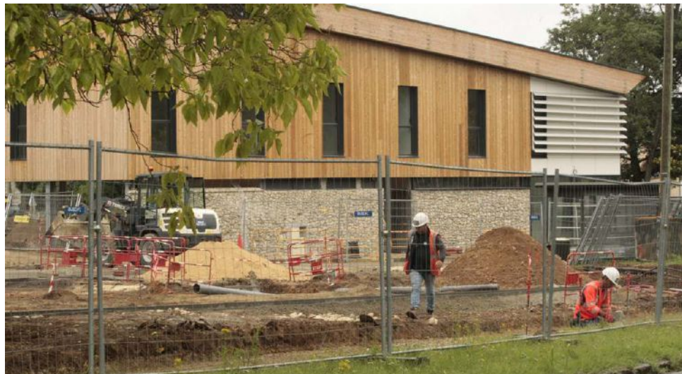
Les travaux du pôle médical de Dammarie-lès-Lys se terminent © La Rep77
